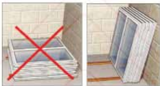
شکل ۲۰ روش های درست و نادرست انبار کردن پنجره ها
